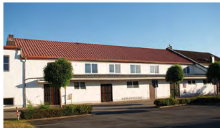
Die Turnhalle nach Abschluss der Renovierungsmaßnahmen
