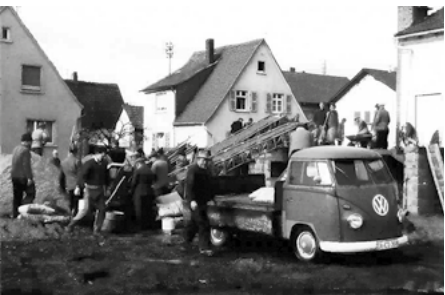
Rohbauarbeiten in Eigenhilfe 1966
